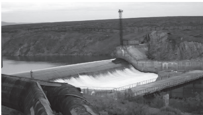
Figura 12.2. Presa vertedero sin compuertas cimentada en suelo.
