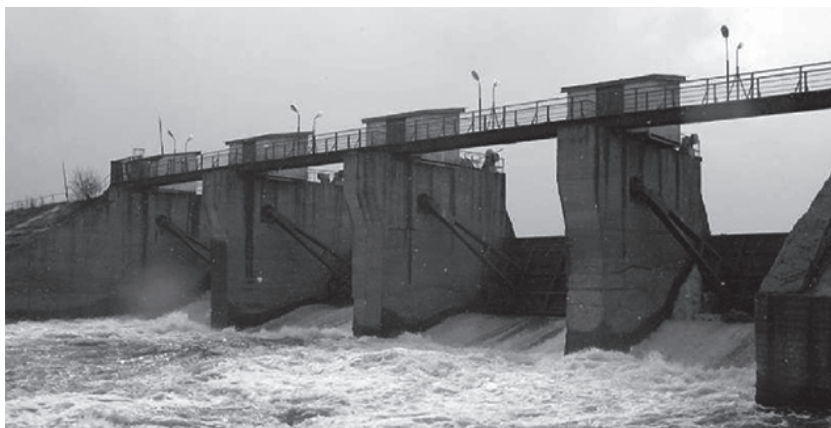
Figura 12.1. Presa vertedero con compuertas cimentada en suelo.
