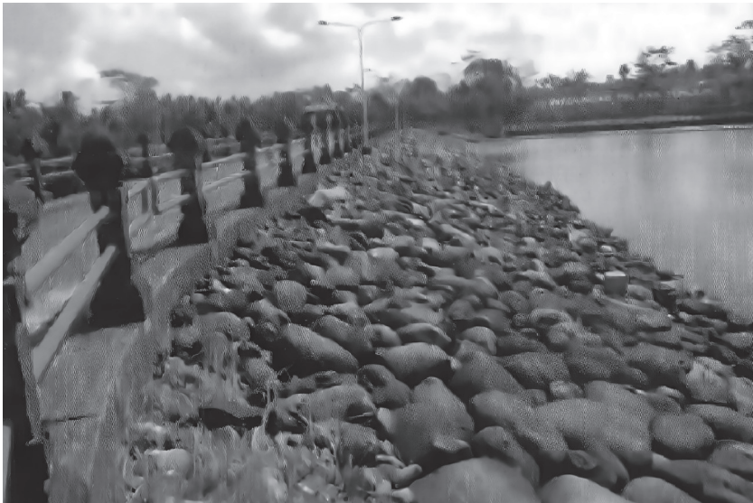
Figura 8.6. Esquema de protección de piedra.
