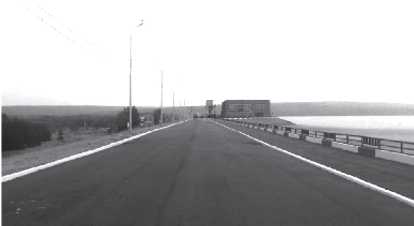
Figura 8.4. Vía en la corona de una presa de material del lugar.
